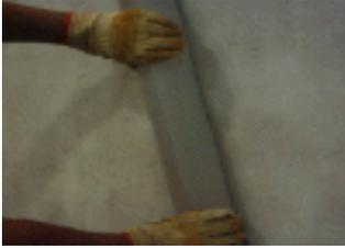
هـ . التأكد من استواء أسطح اللياسات باستخدام القدمة وذلك من خلال وضعها بالعديد من الأماكن والاتجاهات على الحائط والنظر للخط الملاصق للياسة للتأكد من عدم وجود أي فراغ خلف القدمة لدى تحريكها بأي اتجاه . واستخدام الكشاف أو الإضاءة مفيد في هذا الاختبار.
