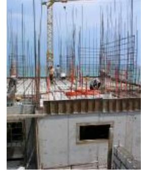
نجد أن أرضية الحمامات والمطابخ وغرف الغسيل تنفذ أرضيتها بالأسقف بمبوط قدرة ١٠. ١٥سم وذلك للمساعدة في عزل أرضيتها وإتاحة مجال لعمل التمديدات الصحية بها . بعض المقاولين يضعون بعض العلب أو الصناديق في أماكن البلاعة أو كوع صرف كرسى الحمام والأفضل أن تتركب كل التمديدات الأرضية قبل الصب . ويجب تحديد نوع الكرسى مسبقاً لتحديد مكان كوع صرف الكرسى (بعده عن الحائط). عند اكتمال أعمال النجارة والحدادة والتمديدات الكهربائية والصحية والميكانيكية يتم تسليمها للمهندس المشرف للتأكد من جودتها ومطابقتها للمخططات.
