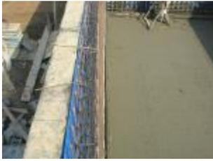
بعد اكتمال العزل يتم عمل حديد التسليح للأرض والحوائط ومن ثم يتم صب خرسانة الأرض أولا وبعد يومين أو ثلاثة يمكن شد نجارة الحوائط وصب خرسانتها وكلاهما بخرسانة من عيار ٤٠٠ كجم/م<sup>٣</sup>. ومن المهم أن يراعى عند صب أرضية الخزان المسلحة عمل ميول إلى الزاوية التي تعلوها فتحة الخزان وذلك لتسهيل شفت المياه وقت الغسل . وقبل صب حوائط الخزان يوضع أسفلها مانع تسرب ماء (Water stopper) وهي قطع تشبه البلاستيك تفيد بمنع تسرب الماء بين
