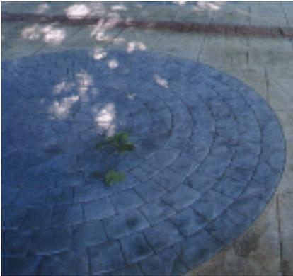
٢-١-٤ / الاستامب كونكريت هي خلطة خرسانية يستخدم بها الاسمنت الأبيض مع رمل أبيض وألوان خاصة . ويتم صب خرسانة الاستامب كونكريت على طبقة رمل تم فرشها ورشها جيدا بالماء وضبط المنسوب بها . ومن ثم يتم وضع طبقة من نايلون سميك يفرد عليه شبك حديد التسليح مع رفعه بمقدار كافٍ (للتمكن الخرسانة من المرور
