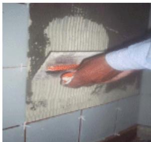
تخشين سطحه (يتم وزن الحائط باللياسة) ومن ثم يتم لصق البلاطات بغراء خاص ، هذه الطريقة أفضل لوزن الحوائط كما أن عيوب التنفيذ (التطيل) بها تكون أقل وهي أسرع بالتنفيذ .
