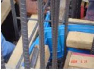
الحائط وأرضية الخزان ، وبعد صب حوائط الخزان بأسبوع (مع الرش بالماء ) يتم شد نجارة سقف الخزان وعمل التسليح وصبه بخرسانة من عيار ٤٠٠ كجم/م<sup>٣</sup>. بعض المقاولين ينسون عمل فتحات تمديد مواسير التغذية والسحب بسقف الخزان فانتبه لذلك.
