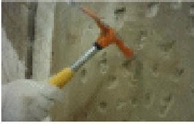
١-٢/ التنقير : ببعض الخرسانات الناعمة يجب تنقيرها لجعل السطح أكثر خشونة للسماح للياسة بالالتصاق بها ، وتحديث الخرسانات الناعمة بسبب استخدام ألواح البلي وود (الكونتر) بنجارة صب خرسانة الأعمدة والكمرات والأسقف . ومن المهم أن نراعي عدم استخدام ألواح البلي وود بصب الخرسانات التي سنقوم بلياستها لاحقاً لكي لا تزيد علينا تكلفة التنقير.
