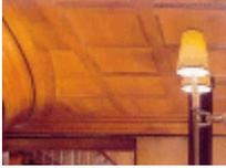
ج. نظام التلبيس بسقف خشبي . وهو المثبت بالسقف الخرساني مباشرة (لا يوجد فراغ بينهما) ، وهو لغرض جمالي فقط ويساعد على إخفاء عيوب السقف الخرساني.
