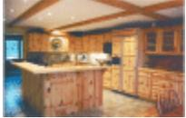
ب. نظام السقف الخشبي الساقط . وهو سقف مستعار بينه وبين السقف الخرساني فراغ ويتم استعماله عادة لأغراض الديكور ويتم استغلال الفراغ الذي يعلوه بتمديدات الميكانيكا مثل التكييف وكذلك لإخفاء عيوب السقف الخرساني.
