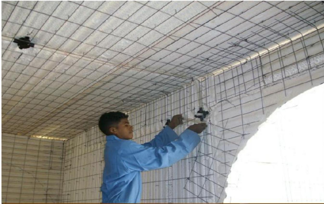
■ تركيب مواسير الكهرباء وتثبيت العلب الحديدية وعلب التوزيع ..
