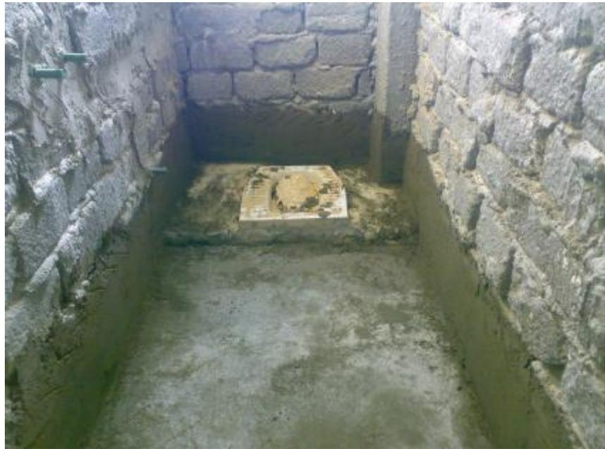
**مع ملاحظة** عمل عتبة من المبانى اسفل حلق باب الحمام يكون منسوبها اقل من منسوب البلاط ب ٢ سم فقط لعزلها من الداخل مع باقى حائط الحمام وذلك لامكانية اختبار العزل بملىء الارضية بالماء بإرتفاع ١٠ سم ولضمان عدم تسرب المياه من ارضية الحمام لباقي الشقة عن طريق الرمل الموجود اسفل البلاط لتكون العتبة حاجزا للتسرب حالة حدوثه
